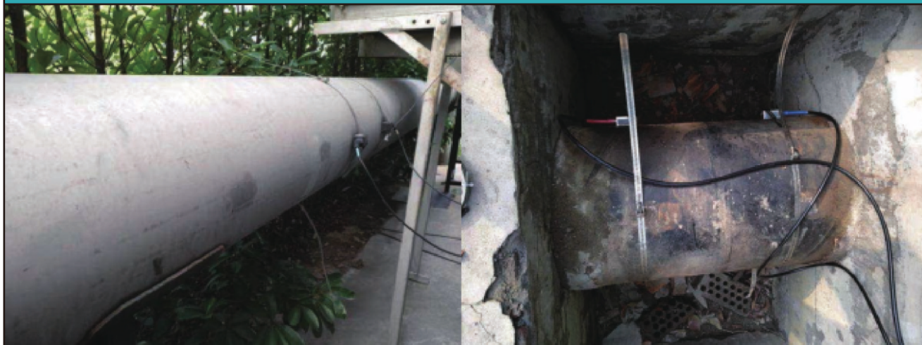
江苏某纸厂清水（左边）及污水（右）采用外夹式传感器DN700
